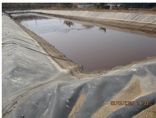
รูปที่ 38 การปูกันซึมบ่อบำบัดน้ำเสียด้วยพลาสติก HDPE
