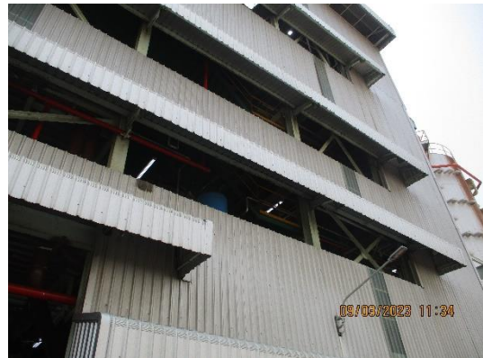
รูปที่ 79 การปิดครอบแหล่งกำเนิดที่มีเสียงดัง
